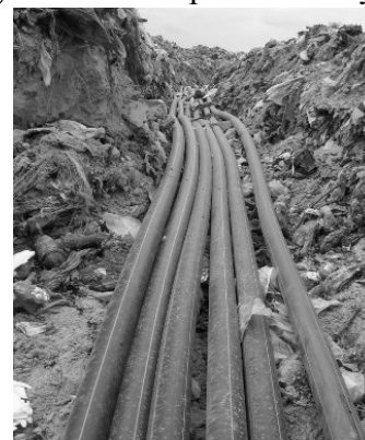
Рис. 7. Прокладання трубопроводів біогазу на полігоні ТПВ
