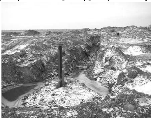
Рис. 6. Газозбірні свердловини
