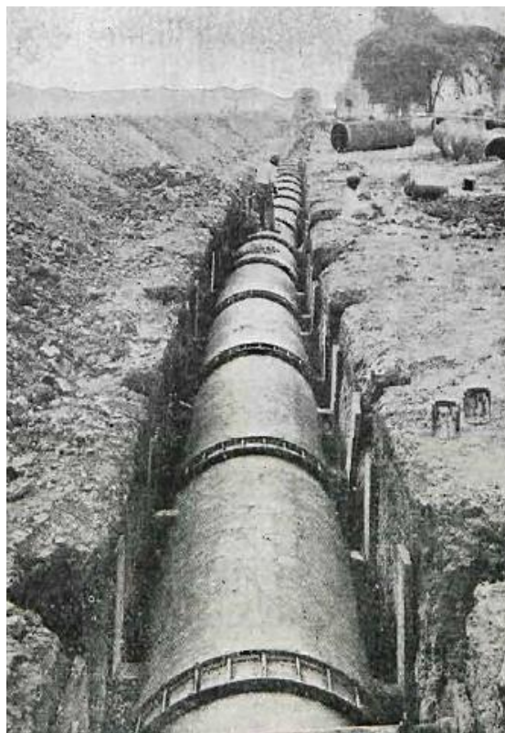
Рис. 1. Будівництво підземного газогону [41]
