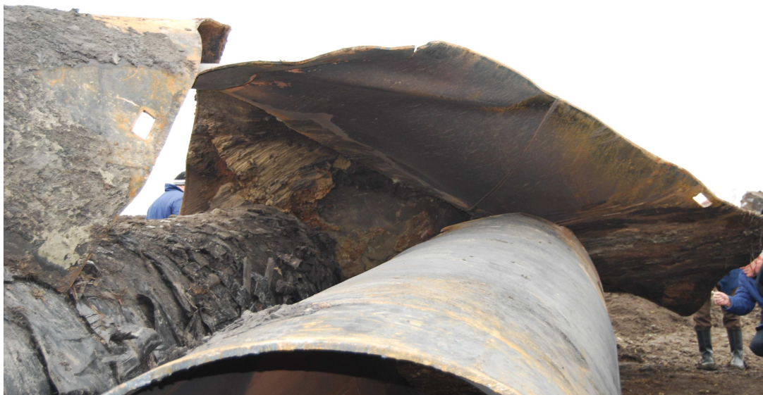
Рис. 1. Аварія з розривом трубопроводу на повне січення
