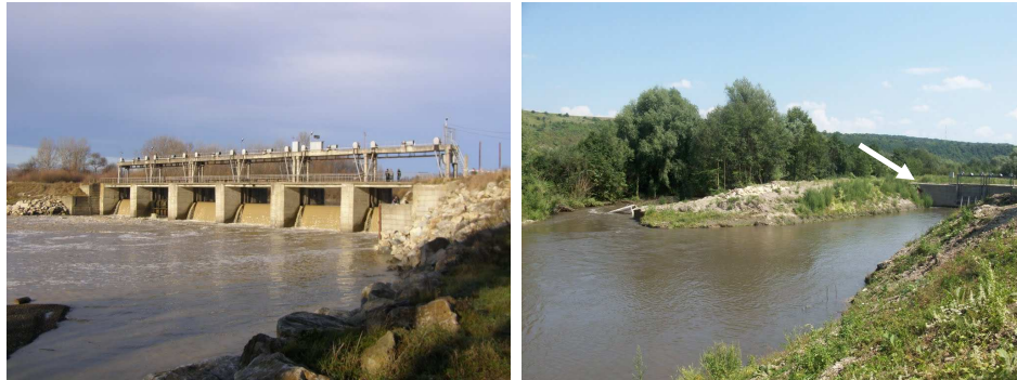
Рис. 3. Об'єкти малої гідроенергетики Прикарпатського регіону: гребля водозабору Снятинської ГЕС; шлюз-регулятор каналу Золотолипської ГЕС
