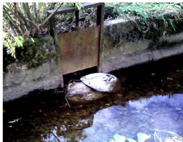
Рис. 4. Перекритий мішками з піском шлюз у відстійник.
