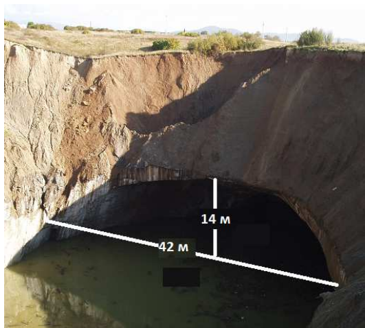
Рис.3. Склепіння над обваленими ціликами (шахта №7 в Солотвині)
